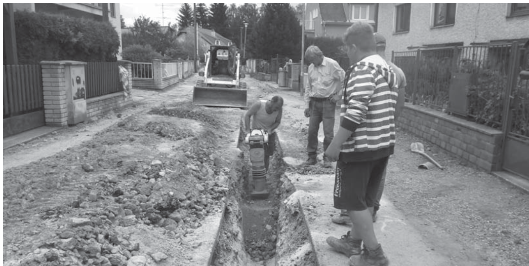
Zaměstnanci firmy Staving CB při hutnění zásypu výkopu.
