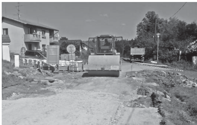
Celková rekonstrukce komunikace se neobejde bez těžké techniky.
