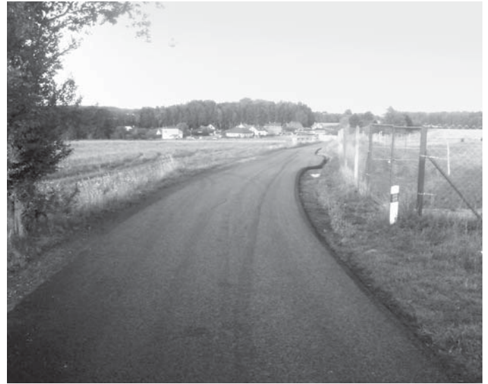
Nový asfaltový povrch Na Štětkách - pohled z Hürky.
