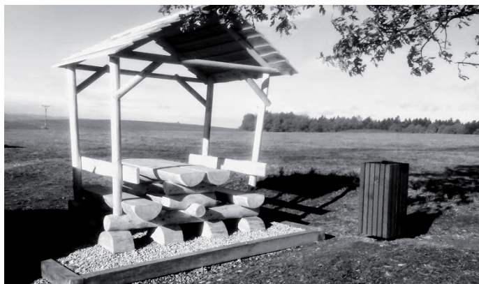
Nově osazený přístřešek na hůrecké vyhlídce.
